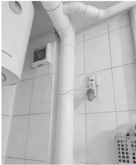
翻新后的水管不再漏水
